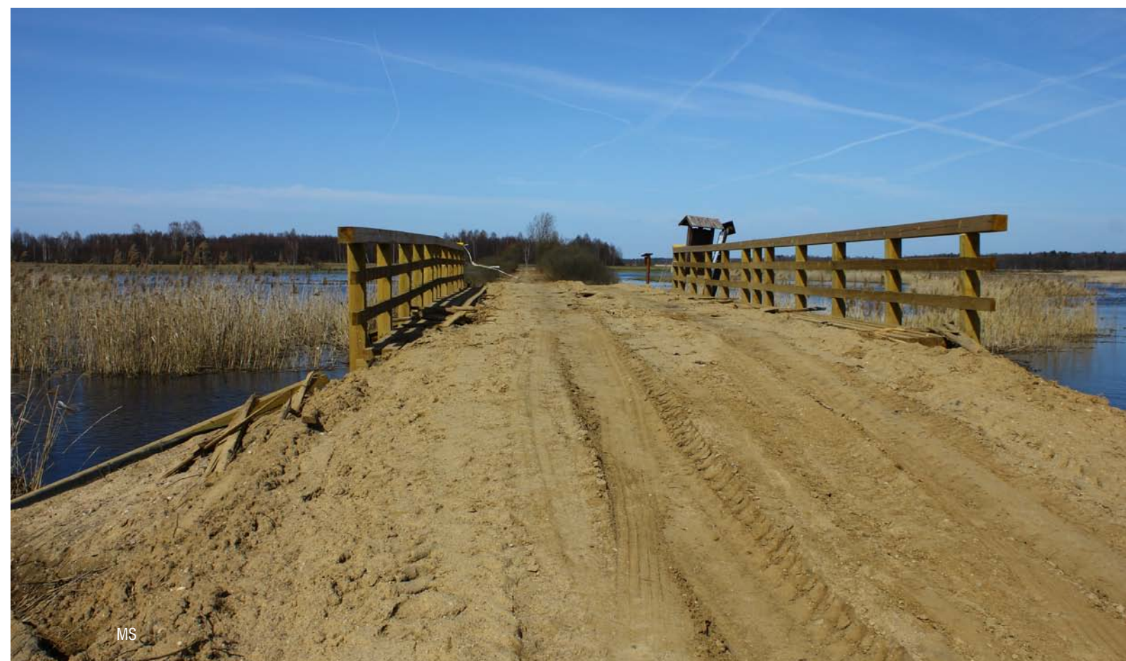
Wyremontowany most na Jęgrzni w Kuligach służy do realizacji celów projektu oraz lokalnej społeczności jako dojazd do bagiennych łąk wymagających czynnej ochrony
