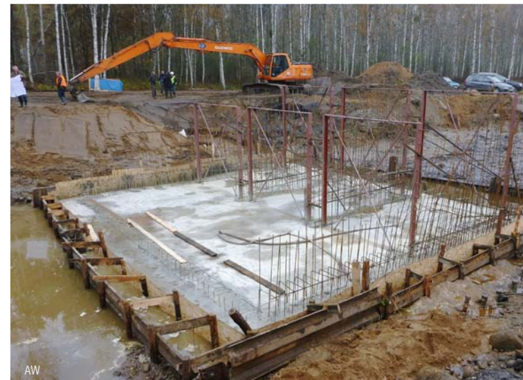
Budowa jazu na Kanale Woźnawiejskim Der Bau des Wehrs Kanal Woźnawiejski The construction of the weir on I Woźnawiejski Canal
