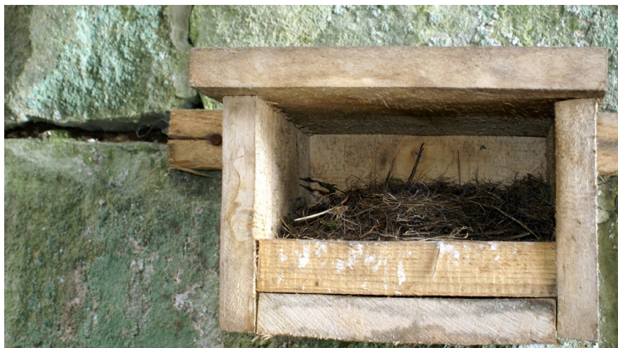
Fot. Budka lęgowa półotwarta. Widoczne pęknięcie listwy w miejscu mocowania, z powodu braku gotowego otworu w miejscu wbicia gwoździa.
